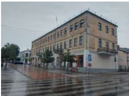
Dzīvojamā māja Rīgas ielā 59, 59C un 59E no ielas puses
